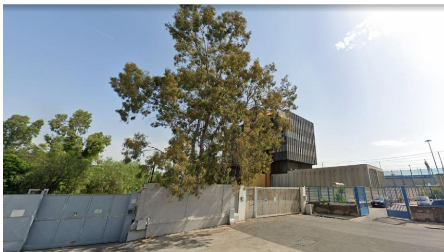
Figura 4 – Sede legale e uffici Edilgen S.p.A.
